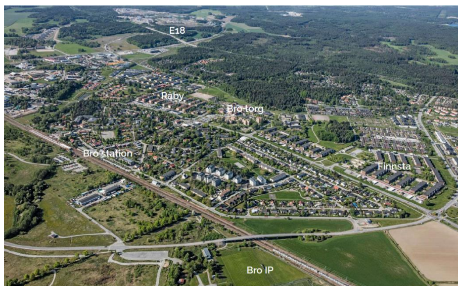
Figur 1. Bro sett från sydost. Bildkälla: FÖP Bro 2040, Upplands-Bro kommun
