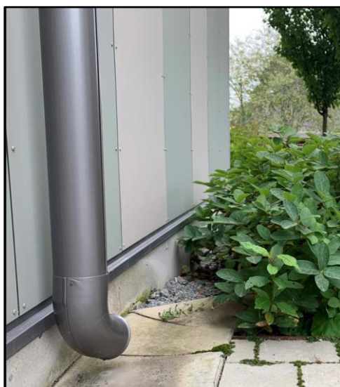
Figur 10-6. Exempel på takavvattning via öppna utkastare och rännalar. (Marktema, 2025)
