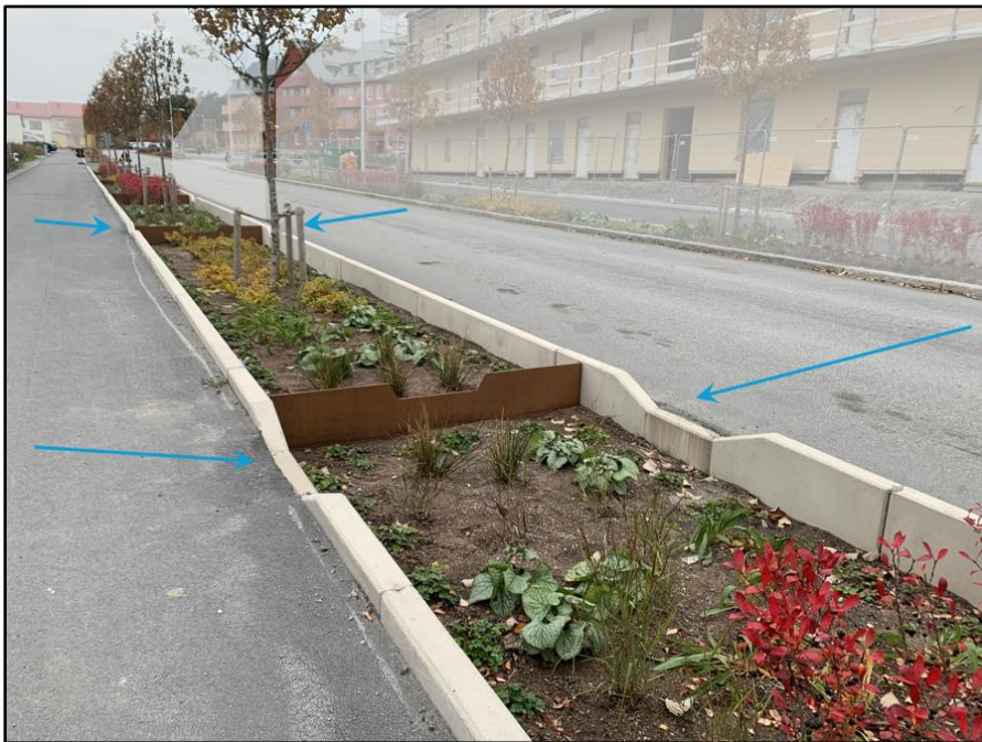
Figur 10-12. Exempel på nedsänkt trädväxtbädd med översvämningszon och vertikala sidor. (Marktema, 2025)
