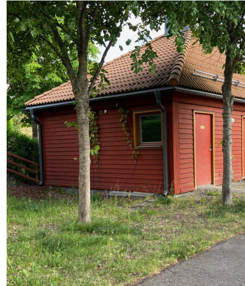
Fint gestaltat miljöhus med sadeltak och fönster.
