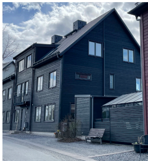
Exempel från Täby på byggnad med träfasad där alla delar av fasaden har fått en fönstesättning vilken bidrar till att aktivera hela fasadytan. En mindre balkong ger liv åt gatan utan att dominera gatumiljön.
