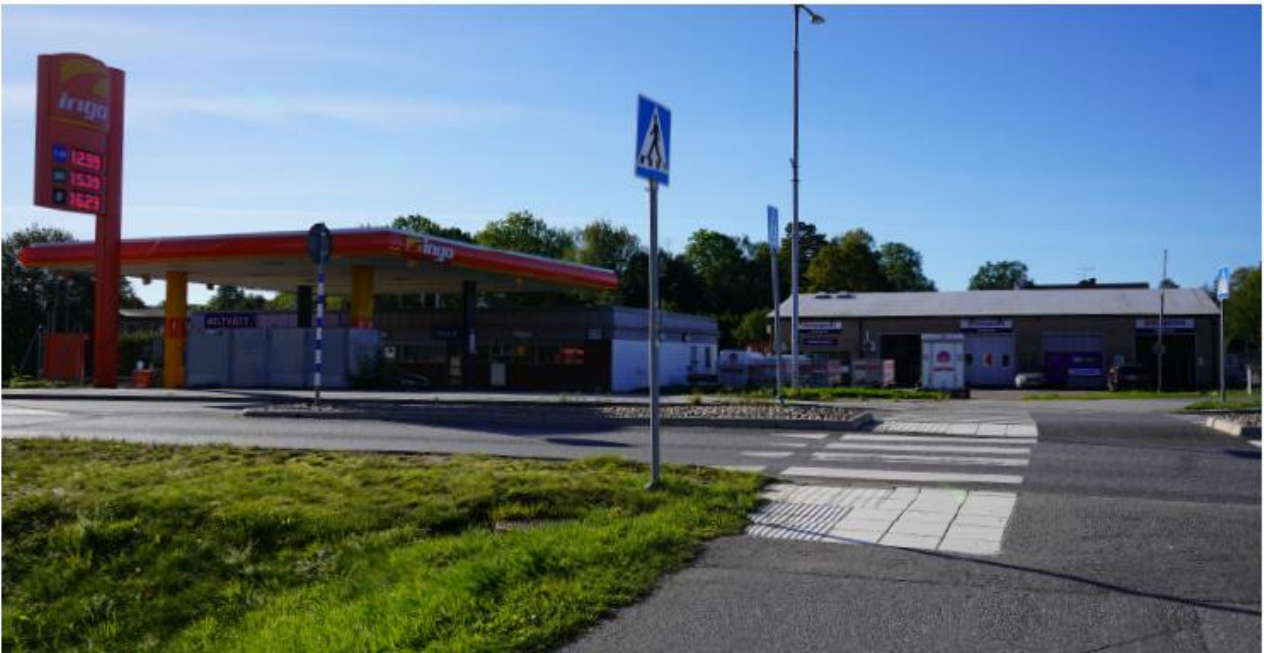
Bensinstation och verkstadslokal i korsningen Enköpingsvägen och Köpmansgatan.
