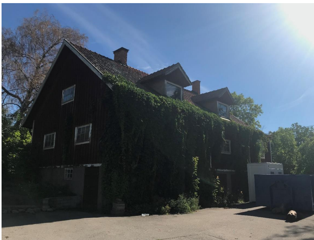
Träbyggnaden som avses rivas
