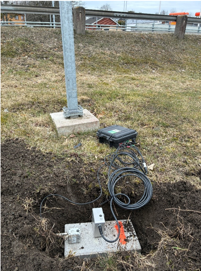
Figur 4: Uppställning för mätpunkt MP1 innan återfyllning.
