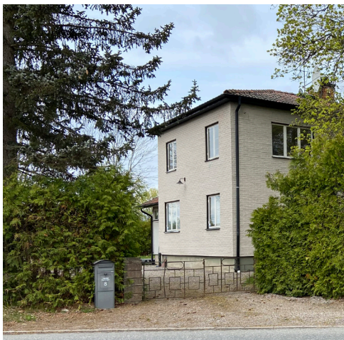
Tidigare villa på fastigheten Härnevi 12:40 revs 2026
