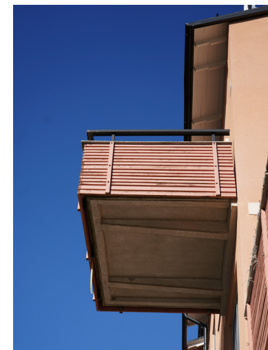
Balkonger med betongbotten och träpanel.
