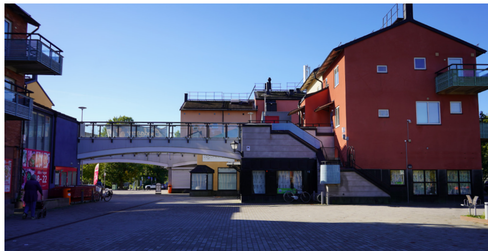
Den norra torgbildningen med de två gångbroarna som förbinder centrumbebyggelsen.
