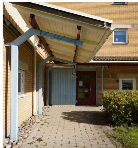
Entréparti med träpanel och skärmtak som bärs upp av stålpelare.
