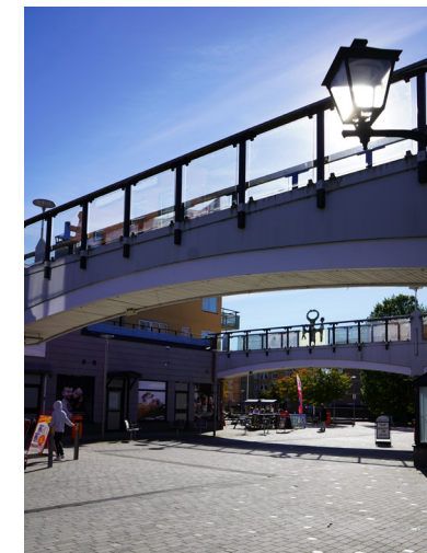
Gångbro och gatulykta.
