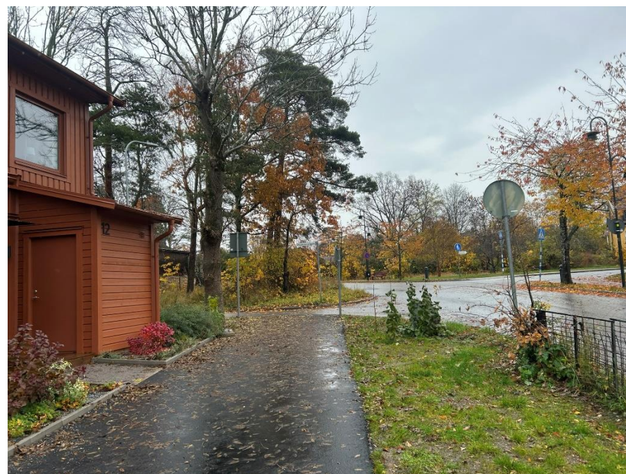
Figur 14. Köpmanvägen i mötet med Prästvågen, en korsning med dålig sikt. Bildkälla: AFRY
