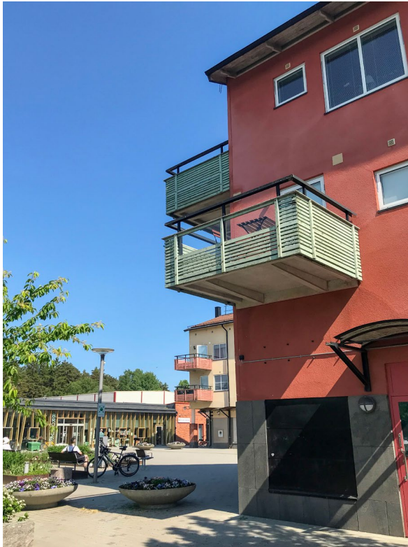
Endast ett fåtal balkonger per fasad. Lägsta höjden för underkant balkong är ca 4 m.
