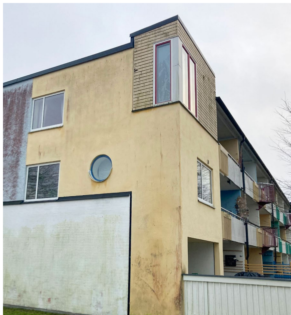
Omdaning av Råby bidrog till fler typer av fasadmateriäl.
