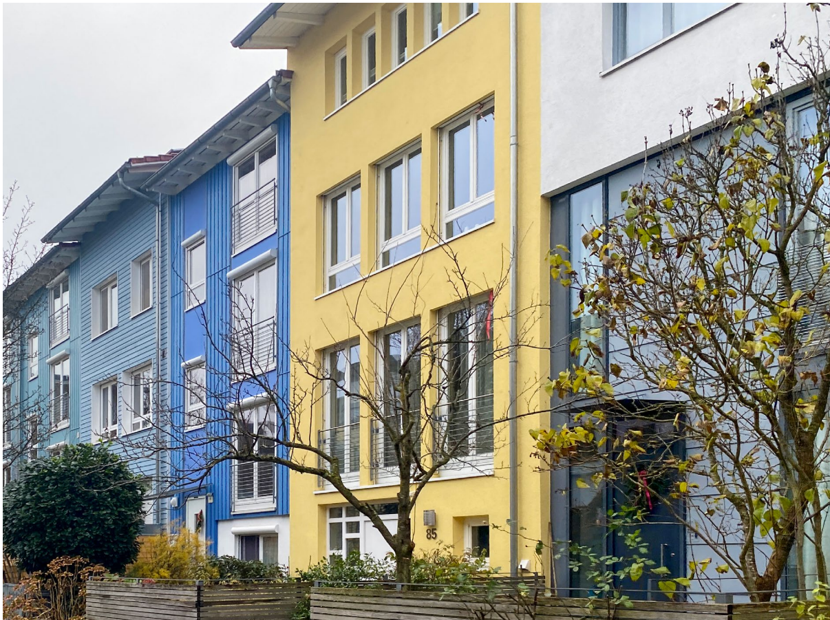
En tydligt vertikal indelning av fasaden bidrar till upplevelsen av småskalighet. Exempel från Freiburg Vauban.
