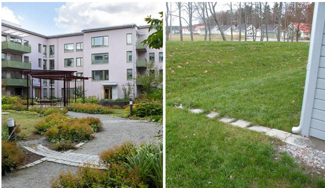
Figur 16. Exempel på ränna (vänster) och utkastare (höger) för avledning av dagvatten. Bilden till höger är från Fasanstigen i Upplands-Bro. Foto: Uppsalahem (vänster), WRS (höger).
