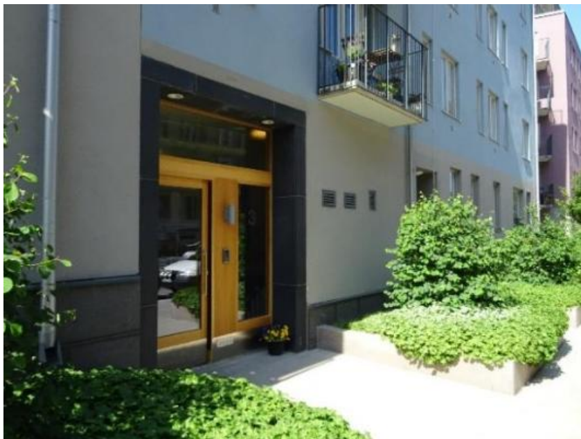
Figur 13. Exempel på regnbäddar för takvatten på förgårdsmark i Stockholm. Foto: WRS.
