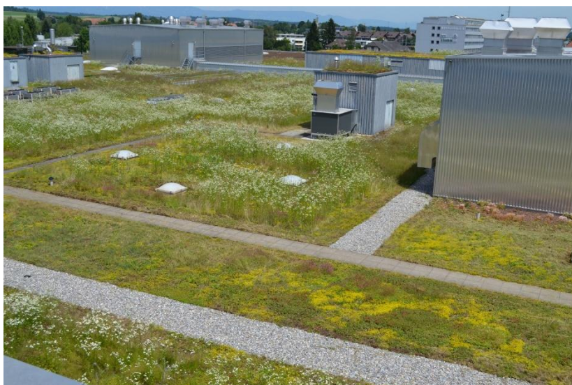
Figur 17. Exempel på utformning av grönt tak med varierad vegetation i Basel, Schweiz. Foto: Nathalie Baumann.
