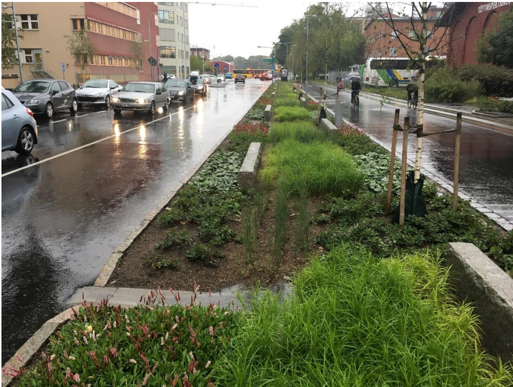
Figur 28. Exempel på utformning av nedsänkta regnbäddar med trädplantering i anslutning till gata, gång- och cykelväg och parkering i Uppsala. Foto: WRS.
