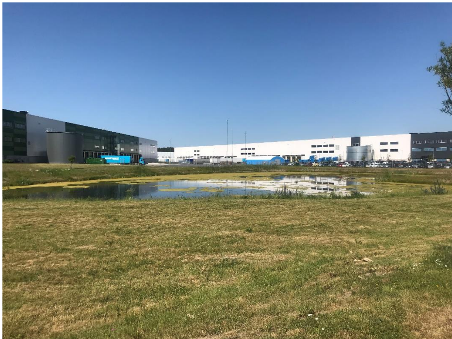
Figur 7. Den befintliga Örnäsdammen vid Garpebodavägen/Örnäsvägen.
