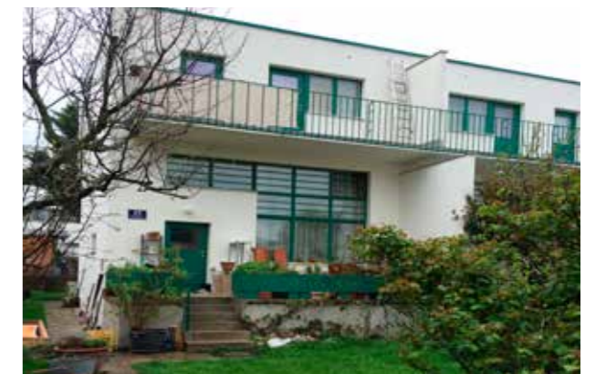
Werkbundsiedlung, Wien, Österrike. 1930. (Bild: C F Möller. Arkitekt Adolf Loos) Välproportionerad förgårdsmark. Enkla, omsorgsfulla byggnader.
