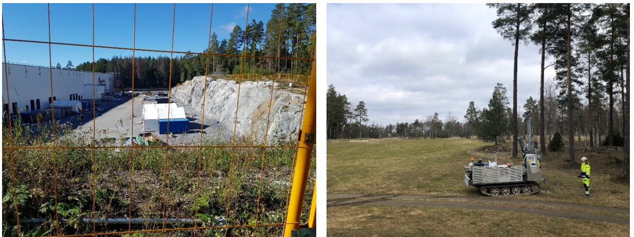
Figur 4.2 Åt vänster, ytnära berg i detaljplaneområdets sydvästra hörn. Bergschakt för intilliggande fastighet framgår även här. Åt höger, sondering intill ytnära fast mark inom skogsområde.
