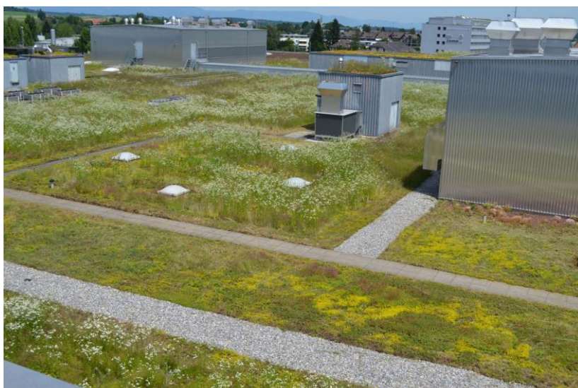
Figur 16. Exempel på utformning av grönt tak med varierad vegetation i Basel, Schweiz. Foto: Nathalie Baumann.
