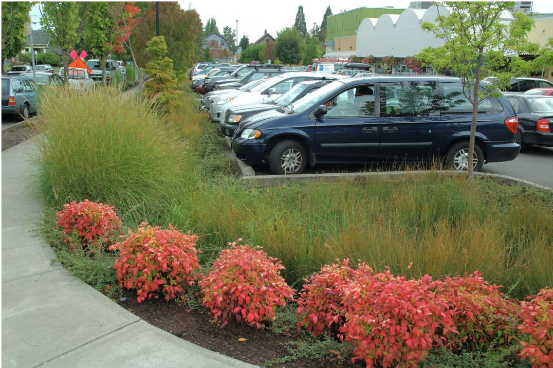
Figur 23. Exempel på nedsänkt regnbädd i anslutning till en parkering. Foto: WRS.
