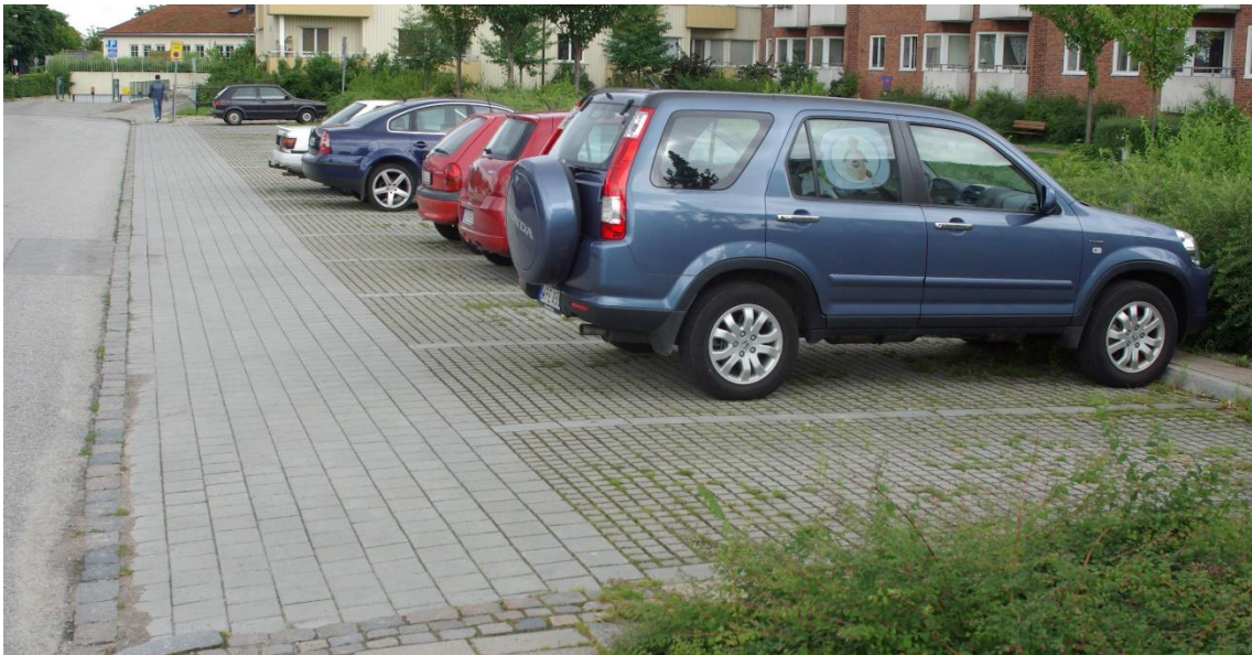
Figur 24. Exempel på parkering med genomsläpplig beläggning. Foto WRS.
