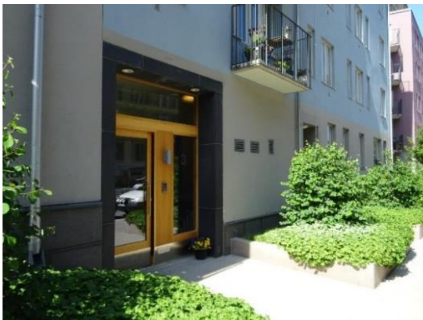
Figur 12. Exempel på regnbäddar för takvatten på förgårdsmark i Stockholm. Foto: WRS.
