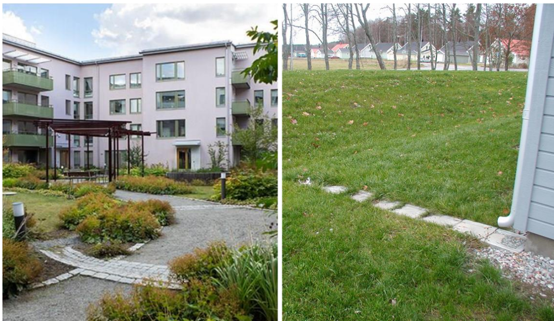
Figur 15. Exempel på ränna (vänster) och utkastare (höger) för avledning av dagvatten. Bilden till höger är från Fasanstigen i Upplands-Bro. Foto: Uppsalahem (vänster), WRS (höger).
