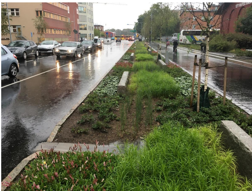
Figur 27. Exempel på utformning av nedsänkta regnbäddar med trädplantering i anslutning till gata, gång- och cykelväg och parkering i Uppsala. Foto: WRS.
