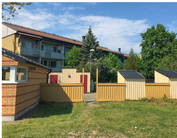
Gårdsmiljöerna avgränsas med staket och komplementbyggnader.
