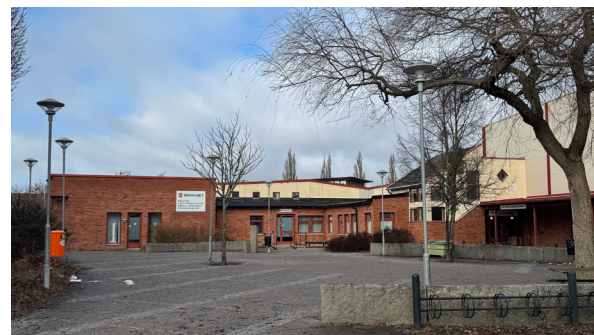
Trygghetscentret vänder mot en offentlig öppen yta. Entrén till sim- och sporthall ligger något gömt, till höger i bild.
