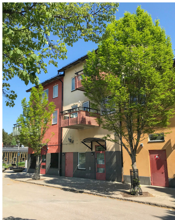
Sockelhöjden varierar mellan 0,5-2,1 m och livar med över- eller underkant fönster.
