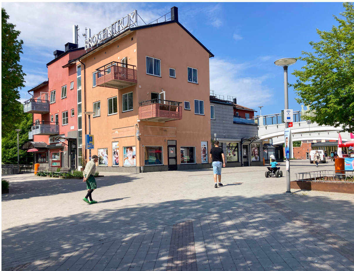
Den befintliga centrumbebyggelsen har lokaler i bottenvåningen och bostäder i två våningar ovanpå.
