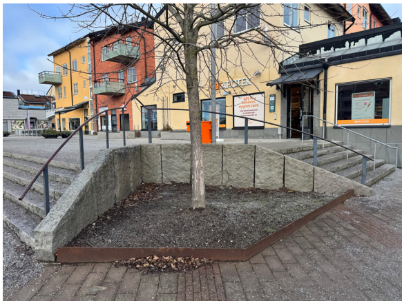
Planteringar inramas av en corténkant.
