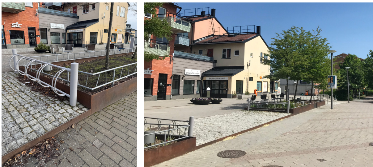
Inramade planteringar i samband med ytor för cykelstall.
