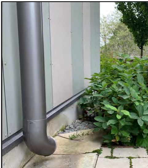
Figur 10-6. Exempel på takavvattnings via öppna utkastare och rännilar. (Marktema, 2025)
