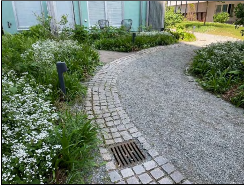
Figur 10-1. Exempel på utformning med genomsläppliga beläggning inom gårdsmark. (Marktema, 2025)
