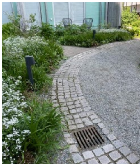
Genomsläpplig beläggning inom gårdsmark, kantad av marksten som ger en tydlig avgränsning av gångytan. (Marktema)
