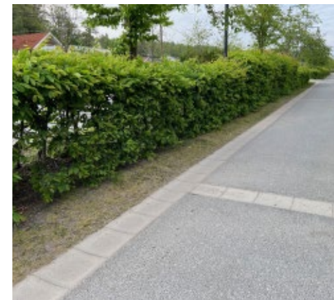
Dagvattenrännor längs gång- och cykelbana.
