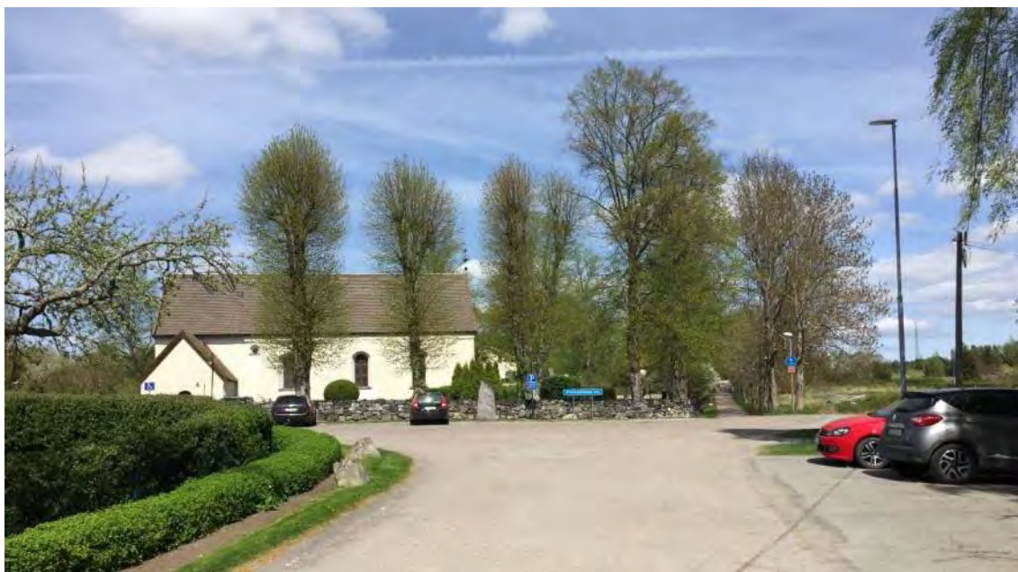
Kungsängens kyrka sedd från söder. Bevarad del av häradsväg från slutet av 1800-talet eller början av 1900-talet syns till höger i bild, som en smal gång- och cykelväg omgiven av allé.
