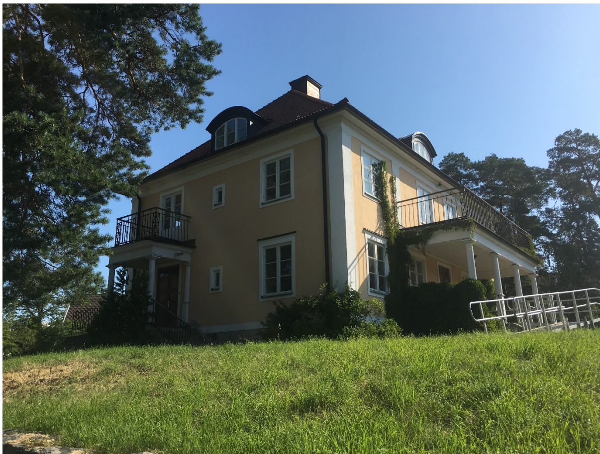
Verandor och balkonger. De kontrasterande detaljerna i fasaden syns tydligt mot den gula putsen.
