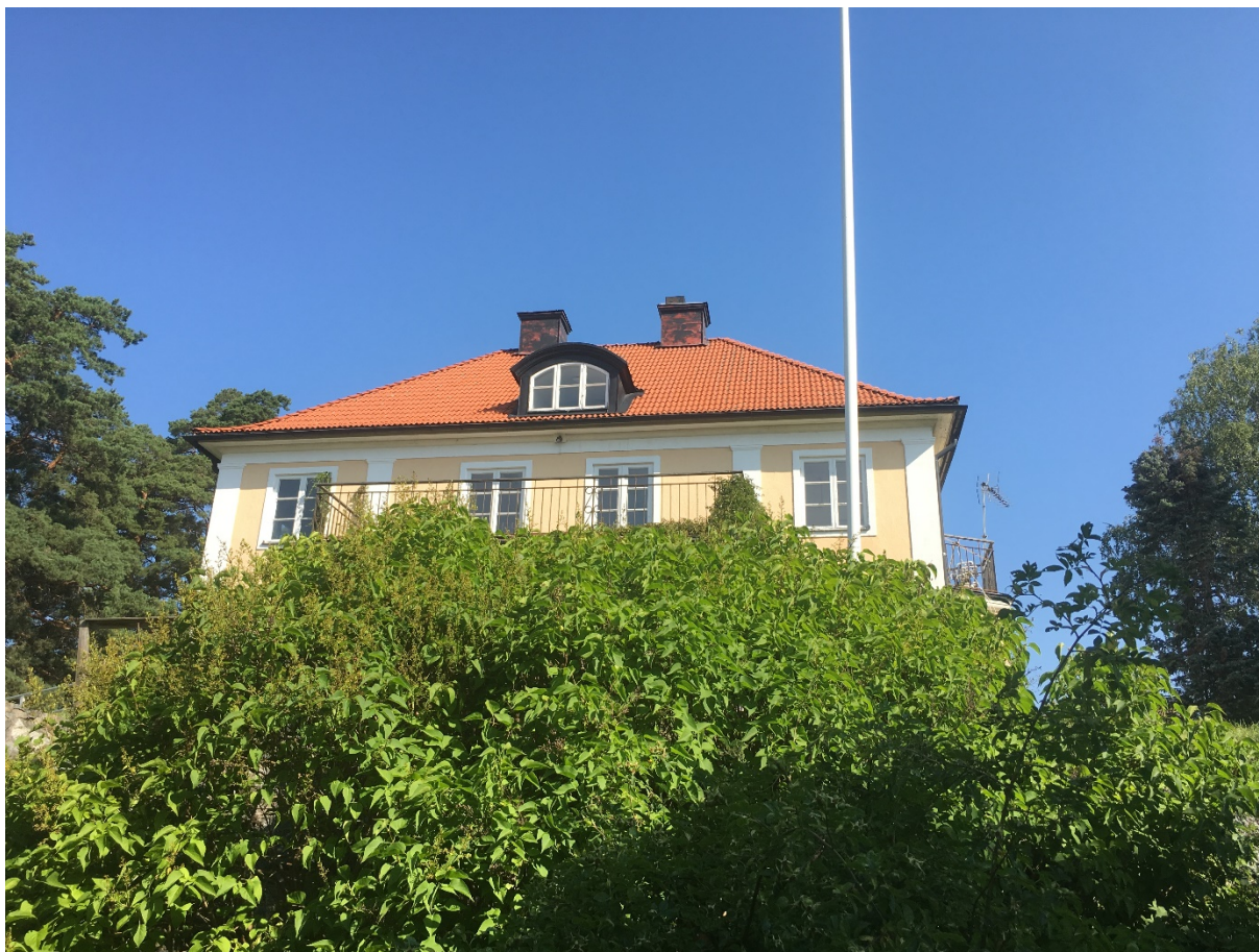
Villa skogas valmade tak med svag utsvängning vid takfoten. Symmetriska skorstenar och en takkupa i varje väderstreck.
