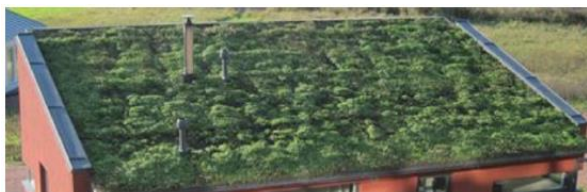
Exempel sedumtak på pulpettak samt fasad i falu rödfärg.
